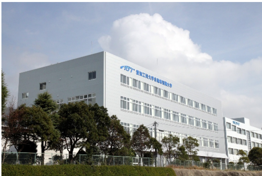
新自動車棟風景（平成 22 年 11 月完成）
